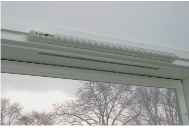
Biobe ThermoPlus -äänenvaimennin-ilma-kanavakasetti eristää ulkoilman ääniä ja ohjaa ilmakiertoa.
