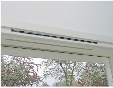
Biobe ThermoPlus -venttiiliä varten tarvitaan työstöt ainoastaan ikkunan yläkarmiin.
